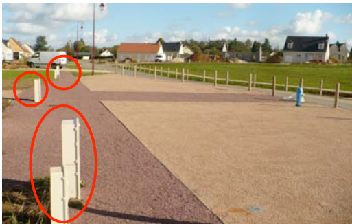
Coffrets éparpillés sur l'espace public,
