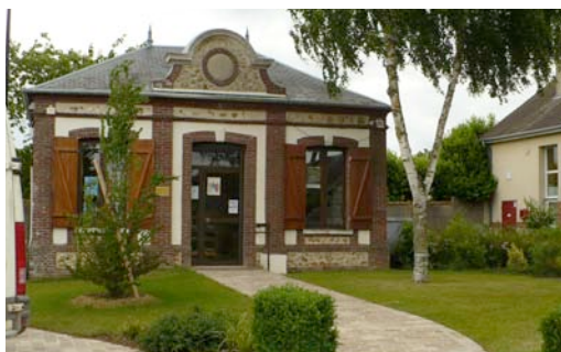
Mise en valeur réciproque du patrimoine et du projet
